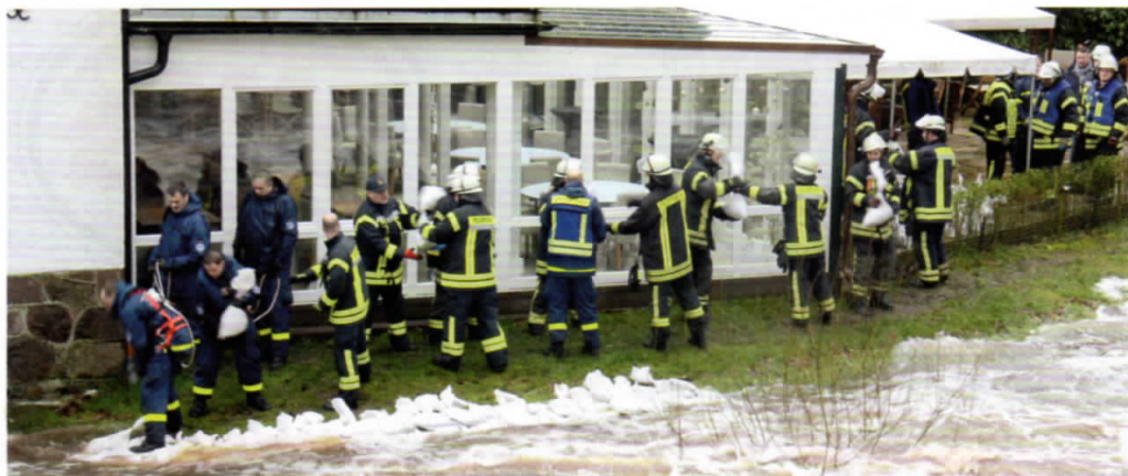
Aus Sicherheitsgründen wurde ein etwa 30m langer Sandsackwall an der Fürst-Bismarck-Mühle gebaut.
